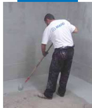
Mapelastic Foundation sprids med roller för vattentätning mot vatten med negativt tryck
