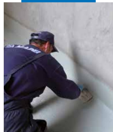
Mapelastic Foundation sprids med spackel för vattentätning mot vatten med negativt tryck
