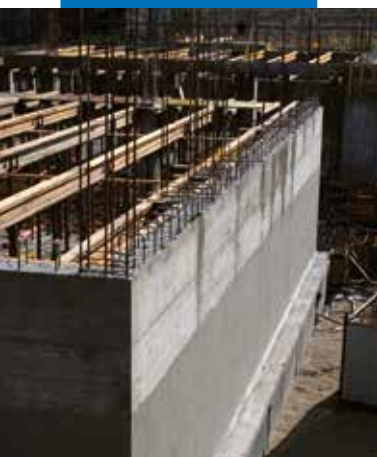
Stödmur som vattentätats med Mapelastic Foundation efter gjutning
