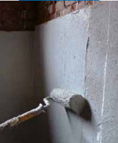
Applicering av Mapelastic Foundation med roller på ett underlag som jämnats av med Planitop HDM Maxi
