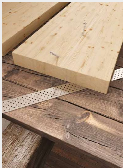
^ Återställning av befintligt bjälklag i trä med hjälp av bjälkar av limträ och fästelement VGZ.
