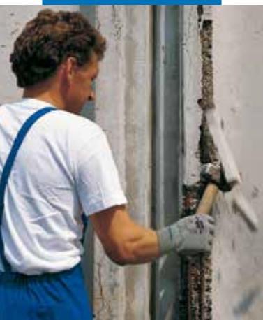
Rivning av gammal, nedbruten betong
