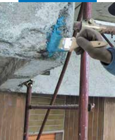
Applicering av Mapefer 1K med pensel på armeringsjärn på en balkong av armerad betong
