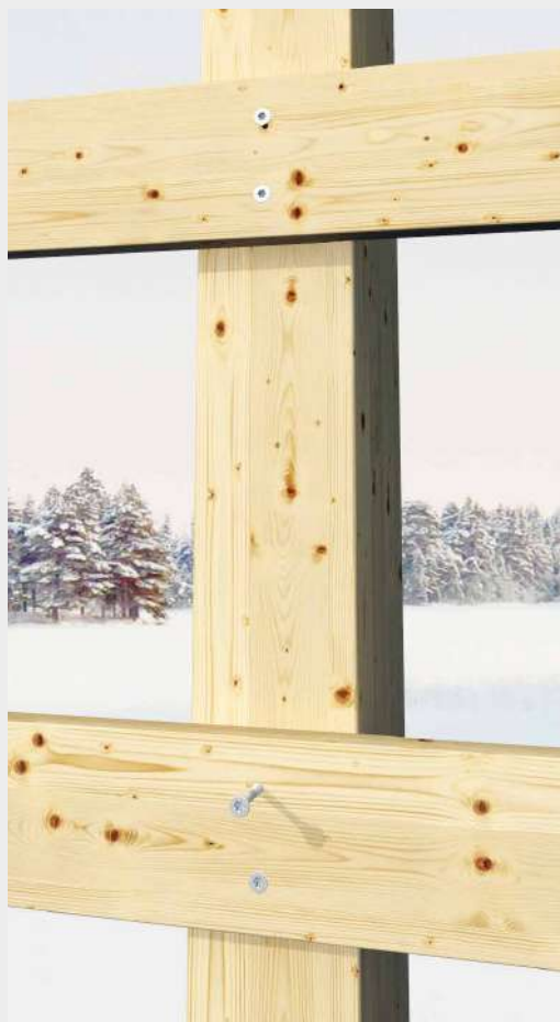
Fastsättning av ett staket utomhus. >
